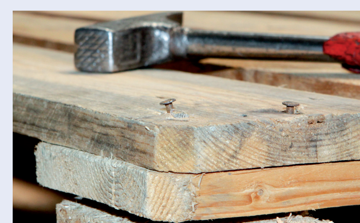
Einschlagen herausstehender Befestigungselemente
